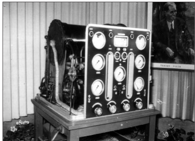
Foto 11 Instalație mobilă de producere a aburului cu Generatoare „Vuia“, construită în România, proiectată și experimentată de Institutul de Documentare Tehnică
