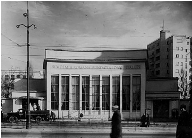
Clădirea Fundației „Ioan Dalles” a Academiei Române, București, 1939
