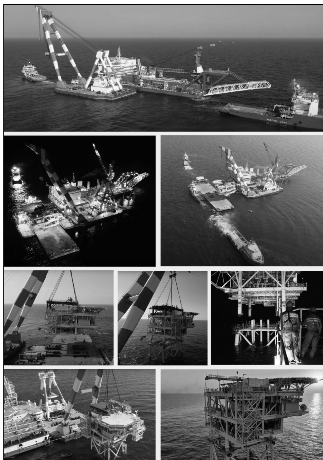
Figura 11. – Prezentarea succesiunii de lucrări de transport și instalare pe locația offshore a părții superioare (topside) a platformei de producție Ana. Se remarcă logistica complexă furnizată de GSP (barja de transport Bigfoot, macaraua plutitoare Neptun) pentru realizarea acestor operațiuni (colaj original de fotografii din arhivele GSP și BSOG, 2021).
