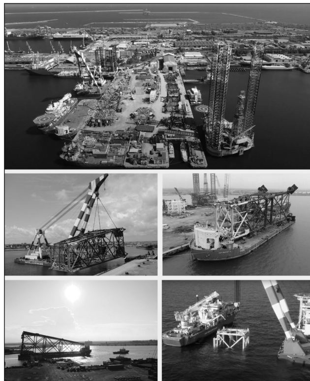
Figura 10. – Prezentarea succesiunii de lucrări de construcție la șantierul naval GSP din portul Agiea, transport și instalare pe locația offshore a structurii submarine de suport a platformei de producție Ana (sursa: colaj original de fotografii din arhivele GSP și BSOG, 2021).
