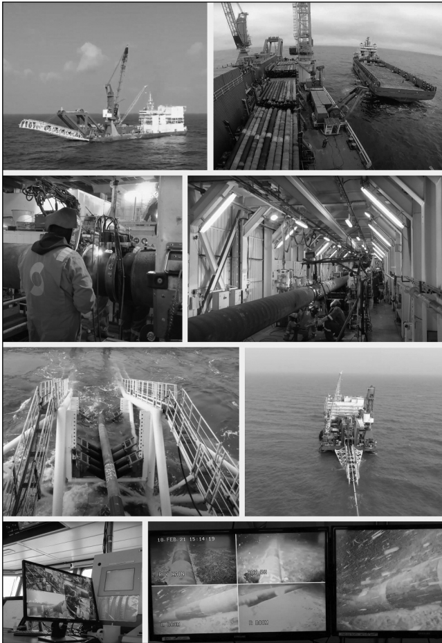
Figura 12. – Prezentarea succesiunii de lucrări de construcție pentru instalarea și lansarea la apă a conductei de gaze pe secțiunea offshore dintre platforma Ana și țărm. Instalarea conductei se realizează prin tehnica „S-lay”, folosind barja de lansare GSP Bigfoot 1. Manevrarea conductei implică sudarea la bordul barjei a îmbinărilor țevilor pentru formarea conductei care este apoi coborâtă de pe pupa barjei pe măsura ce nava înaintază spre larg (sursa: colaj original de fotografii din arhivele GSP și BSOG, 2021).
