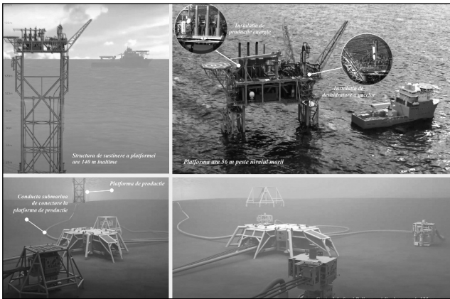
Figura 15. – Prezentare schematică a centrului de foraj submarin Pelican și a platformei de producție offshore, ce vor fi construite pentru valorificarea resurselor comerciale de gaze naturale din sectorul Neptun Deep (sursa: colaj original de fotografii din arhiva ExxonMobil, OMV Petrom, 2021).
