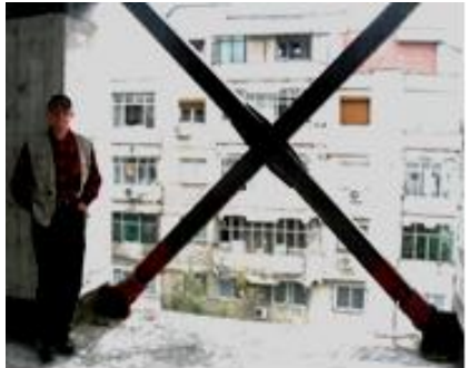
Dr. Tudor Sireteanu la începutul lucrărilor de consolidare
