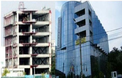
Clădirea înainte și după reabilitare
