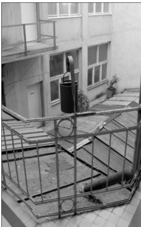
Foaierul înainte de recondiționare
