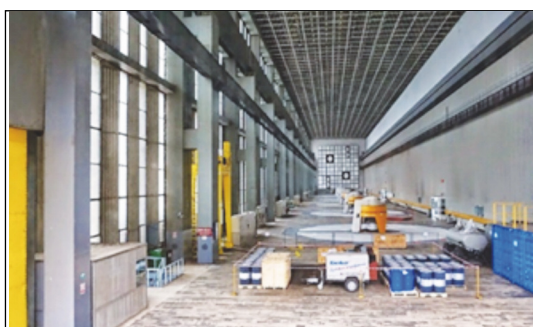
Sala mașinilor de la CHE PF I, cu structura reticulată a acoperișului, sistem care se aplica în premieră în România și podul rulant de 400 t, cel mai mare din țară.
