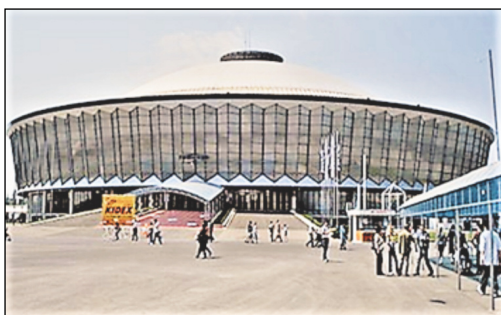
Pavilionul central ROMEXPO și structura metalică a acoperișului în soluția Mateescu, cu o deschidere de 90 de metri și astăzi încă cea mai mare din țară.
