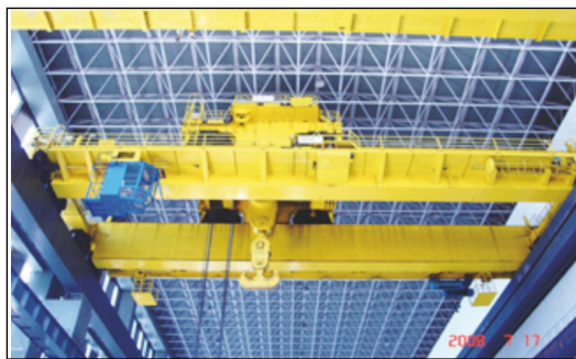
Sala mașinilor de la CHE PF I, cu structura reticulată a acoperișului, sistem care se aplica în premieră în România și podul rulant de 400 t, cel mai mare din țară.
