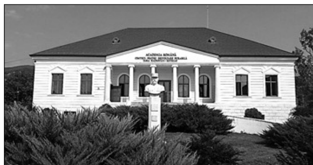
Conacul Berthelot înainte de renovare – 2009 Conacul Berthelot după renovare – 2010
