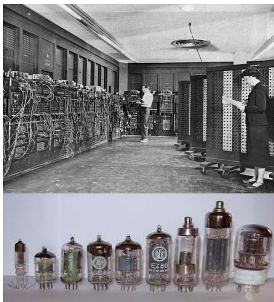
Calculatorul ENIAC realizat cu tuburi electronice.
