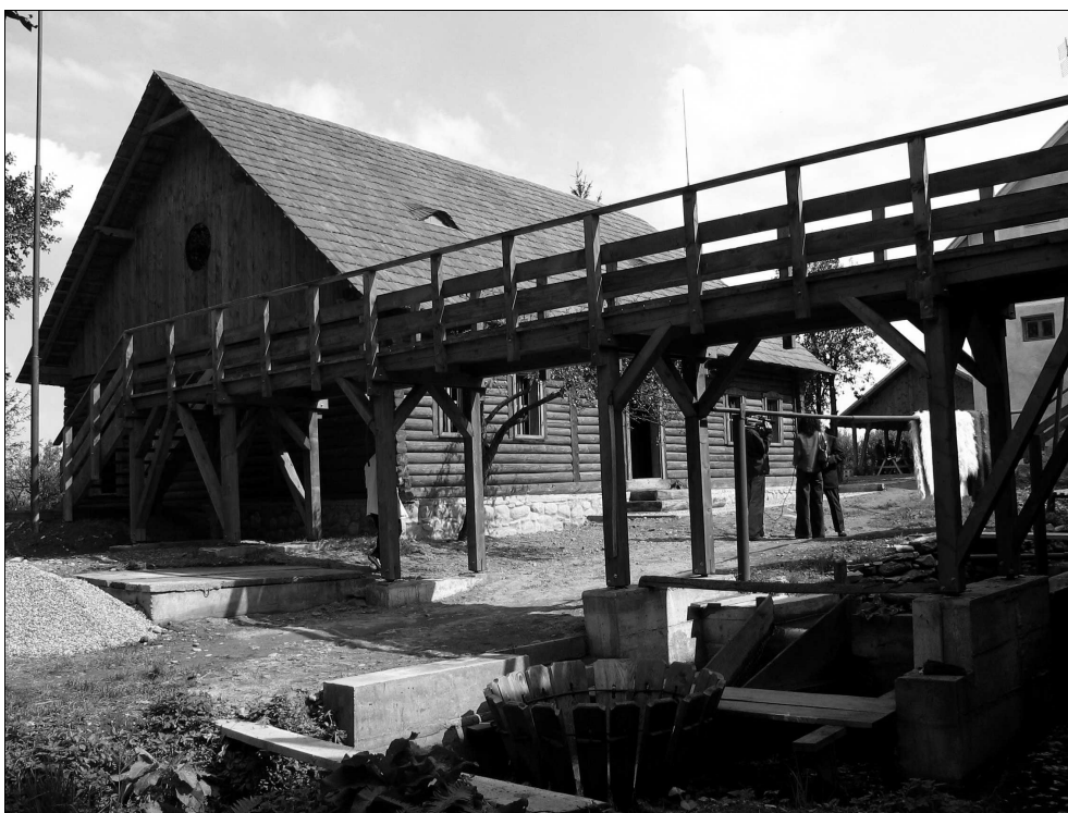
Fig. 7a – Complexul de instalații acționate hidraulic specializate în finisarea textilelor groase de la Lisa, jud. Brașov: vâltoare.
