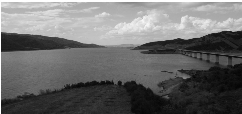
Foto 7. Râul Devoll îndiguit și, în depărtare, barajul hidrocentralei Banjë.
